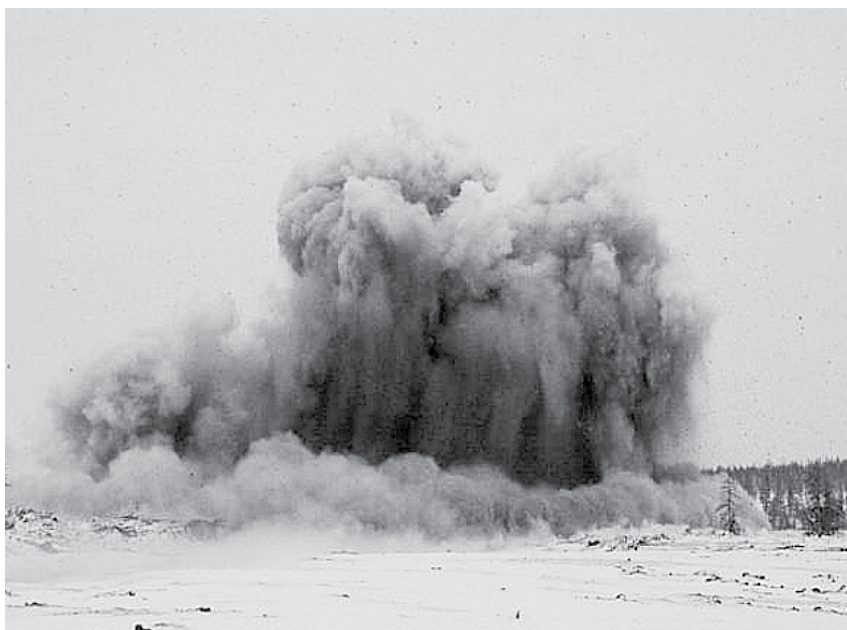
Рисунок 1 – Производство взрыва при геологоразведочных работах
